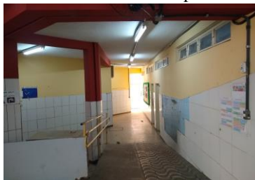
Foto 14 - Corredor do piso 1
