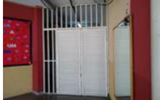
Foto 2 – Portão de acesso
