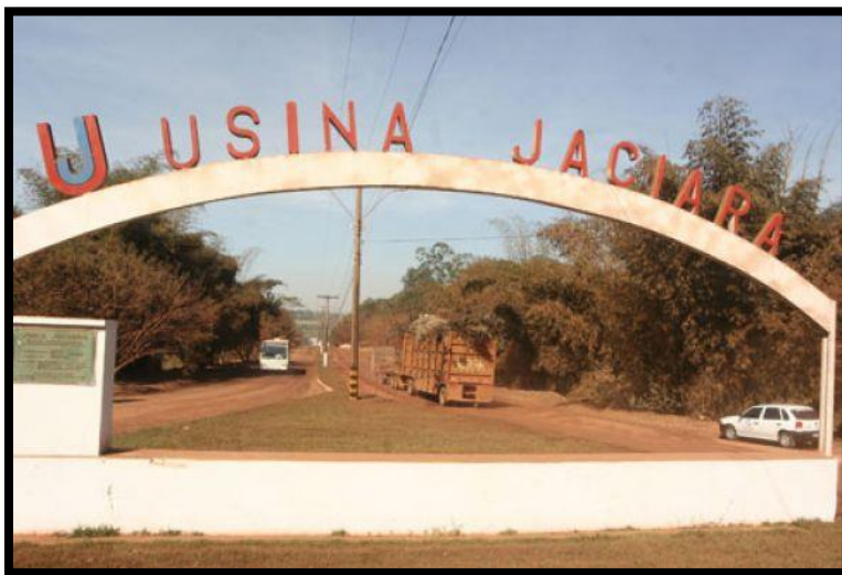
Figura 22 – Entrada da Usina Jaciara.
