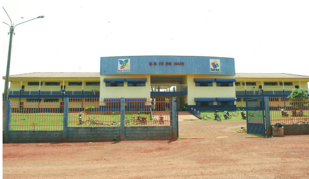
Figura 5: Vista frontal do prédio da Escola 13 de Maio, com o nome atual “Escola Estadual 13 de Maio” (década de 2000) Fonte: Solange Zarth
