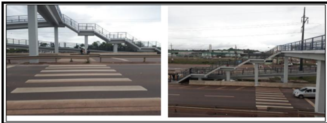
Figura 1: Passarela e faixa de pedestres localizadas em à instituição de ensino.
