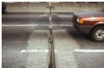
Figura 3 – Junta de dilatação. (Disponível em www.tecpont.com.br/cebolao.htm - Acesso em: 12 jun. 2009)
