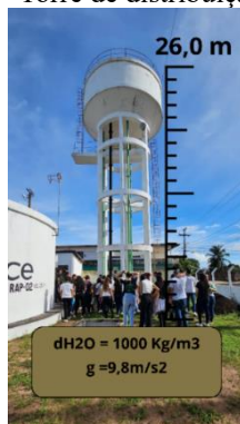
Figura 4 – Torre de distribuição de água.
