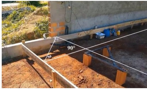
Figura 10 - O uso de esquadrejamento na fundação de uma construção Fonte: Autoria própria
