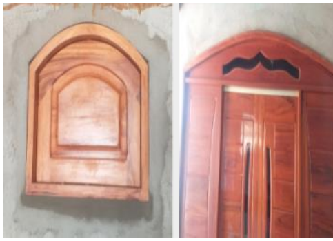
Figura 12 - Arcos em balancim e janela na construção civil Fonte: Autoria própria
