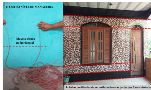
Figura 5 - Aplicação da lei de Stevin na medida de uma altura de uma parede Fonte: Autoria própria
