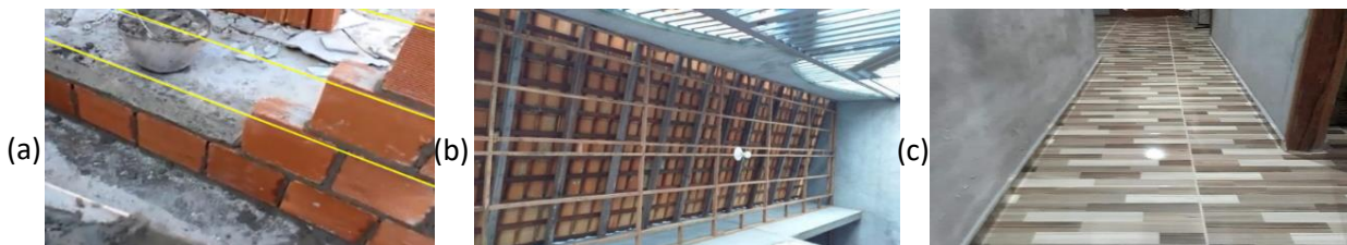
Figura 19 - Retas paralelas presentes em: (a) linha de nylon no assentamento de tijolos em parede, (b) estrutura de madeira para forro, (c) piso de cerâmica Fonte: Autoria própria
