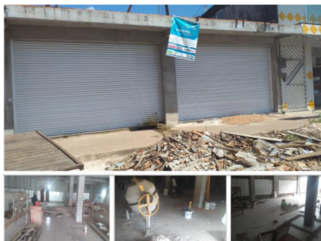
Figura 22 - Prédio do local da pesquisa e sua parte interior em construção Fonte: Autoria própria
