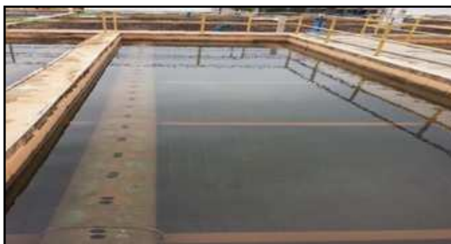
Figura 6: Tanque de decantação. Fonte: A autora (2017).
