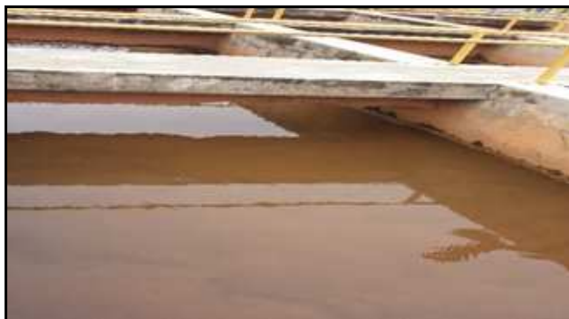
Figura 5: Tanque de floculação. Fonte: A autora (2017).
