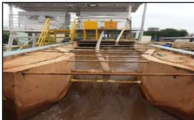
Figura 4: A entrada da água bruta na ETA. Fonte: A autora (2017).
