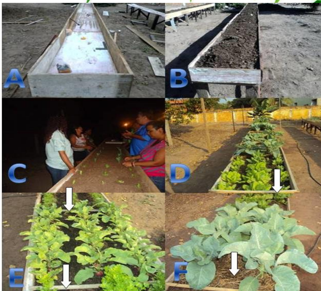
Figura 3: Diferentes fases da construção horta sensorial: A) montagem canteiro suspenso, B) adubação orgânica dos canteiros, C) transplântio das culturas para o canteiro, D) culturas em fase crescimento (detalhe trava com ripão das tábuas que formam o canteiro), E) estrutura de madeira (cabo vassoura) dividindo a área de cada cultivar, F) trato cultural “cobertura morta do solo”. Fonte: Eurico Cabreira dos Santos (2015).
